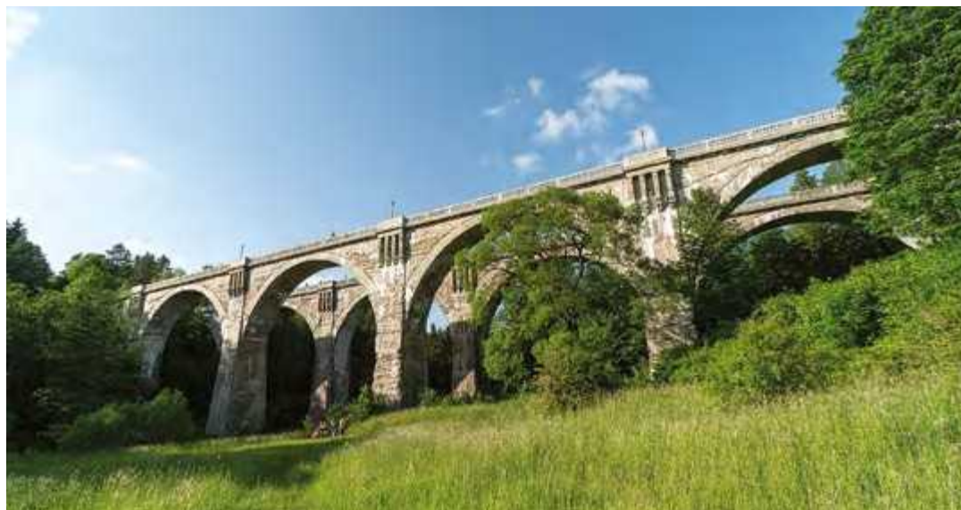
■ Mosty kolejowe w Stańczykach Railway bridges in Stańczyki
