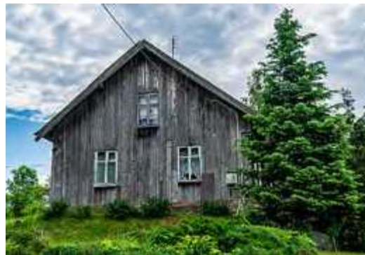
■ Budynki gospodarcze w Bożem Farm buildings in Boże
